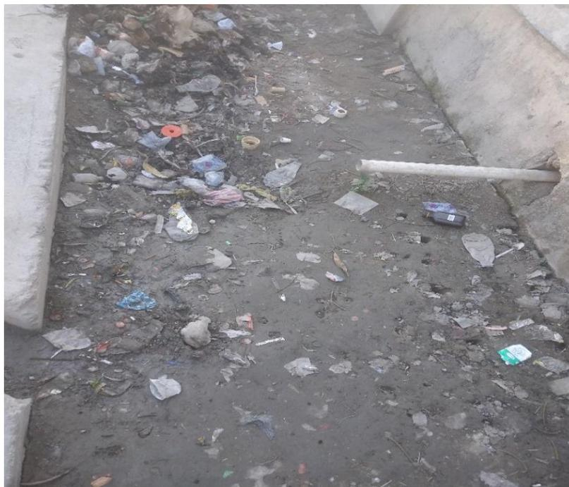
**Figure 19** - Tronçon rempli de sédiments au niveau de Tabarre 2.
