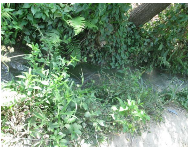
Figure 5 : Tronçon d'un canal tertiaire très enherbé
