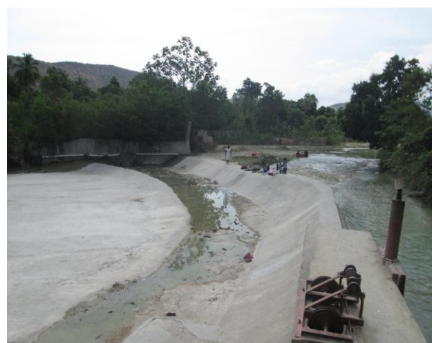
Figure 5 : Seuil-déversoir au travers de la rivière dérivant l'eau dans le canal tête morte
