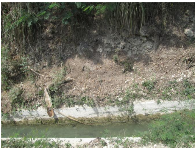
Figure 4 : Canal primaire au flanc d'un versant sans protection pour empêcher la sédimentation
