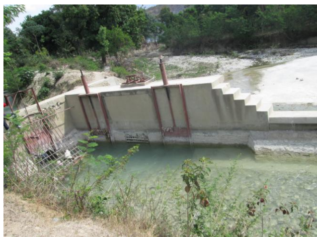
Figure 4 : Les 2 vannes de chasse du réseau et la vanne d'entrée accompagnée de sa grille
