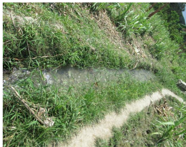
Figure 6 : Partie d'un canal secondaire en terre battue faisant suite à la partie en maçonnerie
