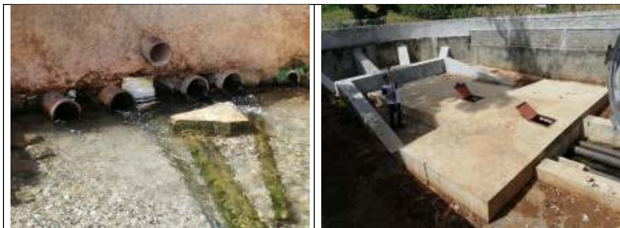
Figure 3. Canalisations de décharge du côté nord de la clôture (à gauche) à la sortie du captage de la source (à droite)
