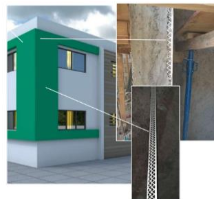
ON VA UTILERER DU CANTO ET APRES ON VA LE REMPLIR AVEC DU MORTIER
