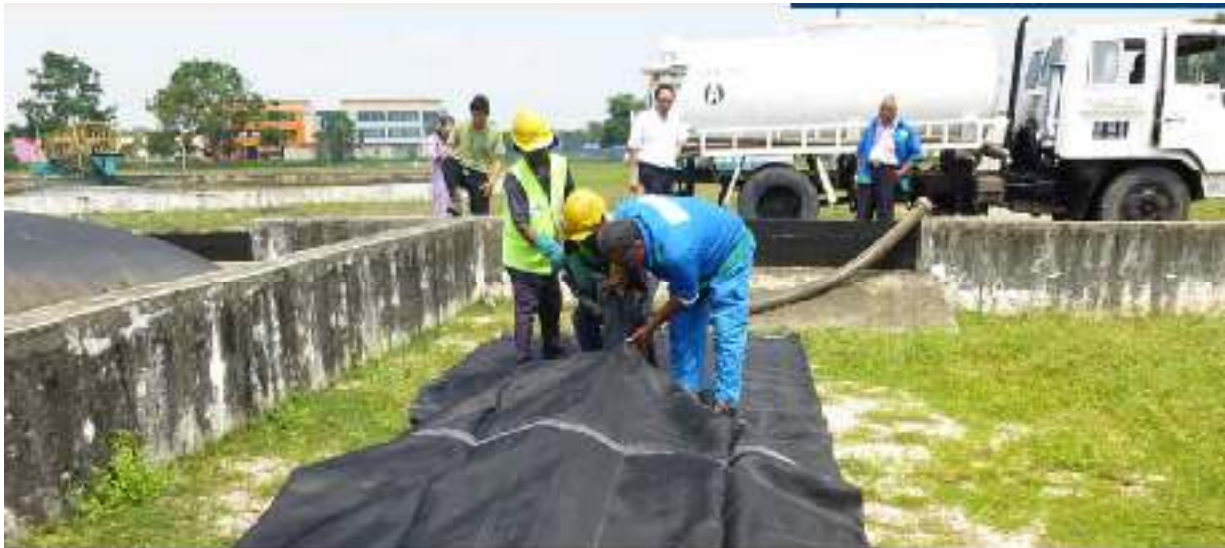
Figure 2. (Source: TenCateGeotube) / Technologie d'assèchement (déshydratation) à l'aide de tubes géotextiles
