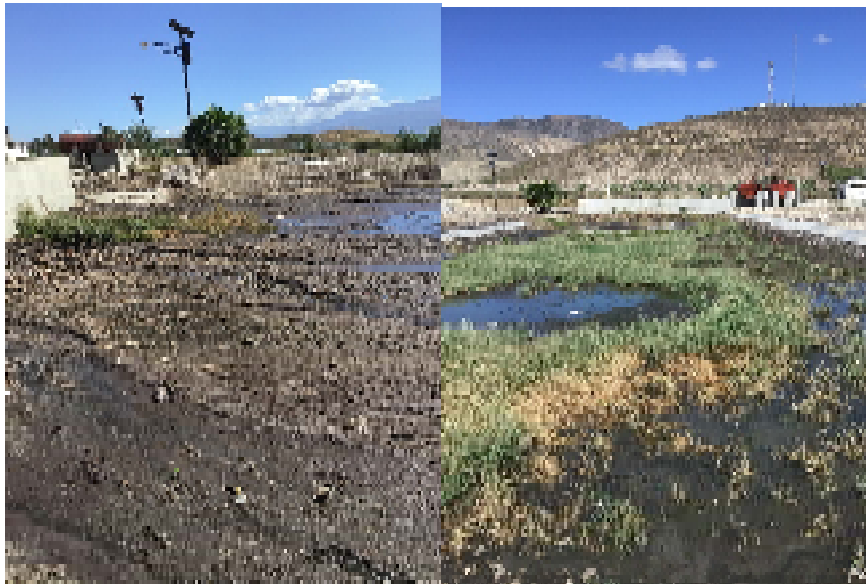
Figure 1. Bassins anaérobies remplis de boues à Morne-à-Cabri
