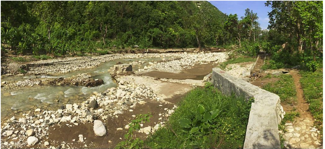
Vue de la prise détruite par le passage de l'ouragan Matthew
