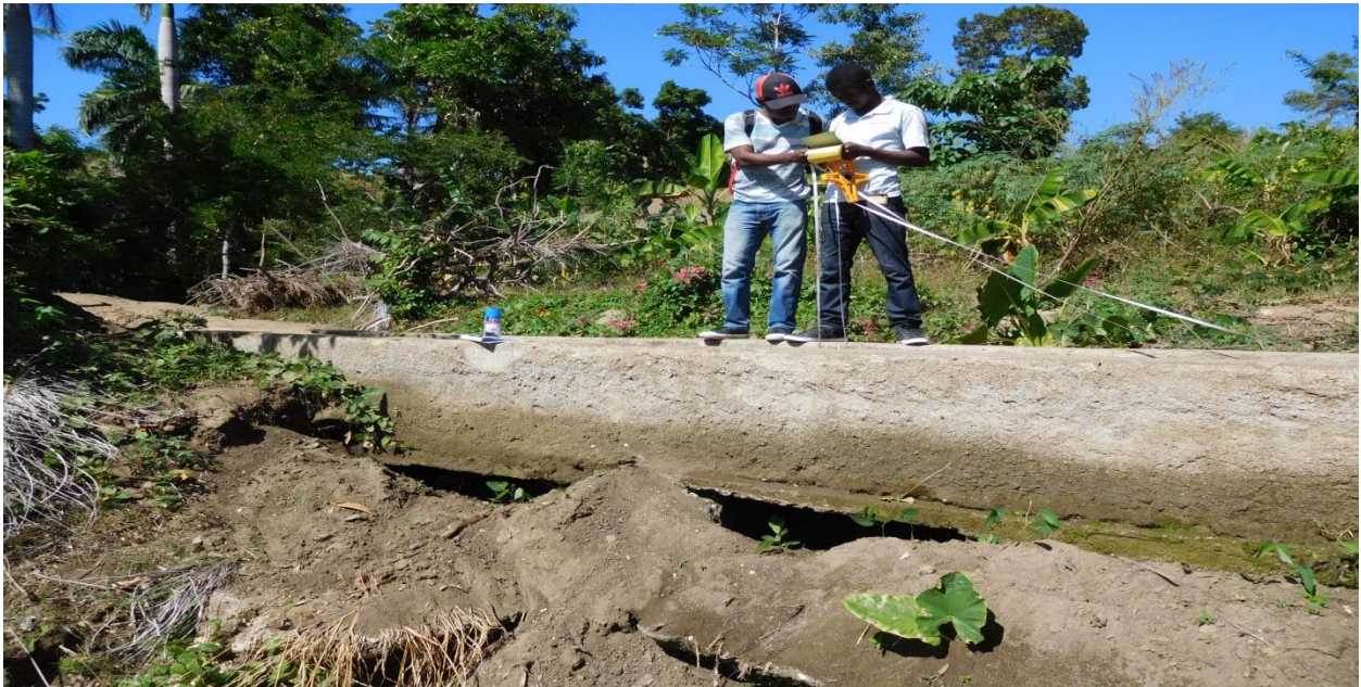
Figure 10: Drain non opérationnel sous l'aqueduc
