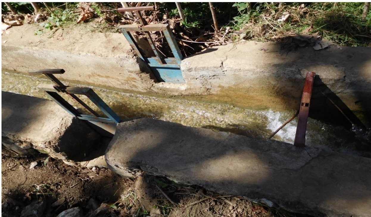
Figure 11: Vannette détériorée
