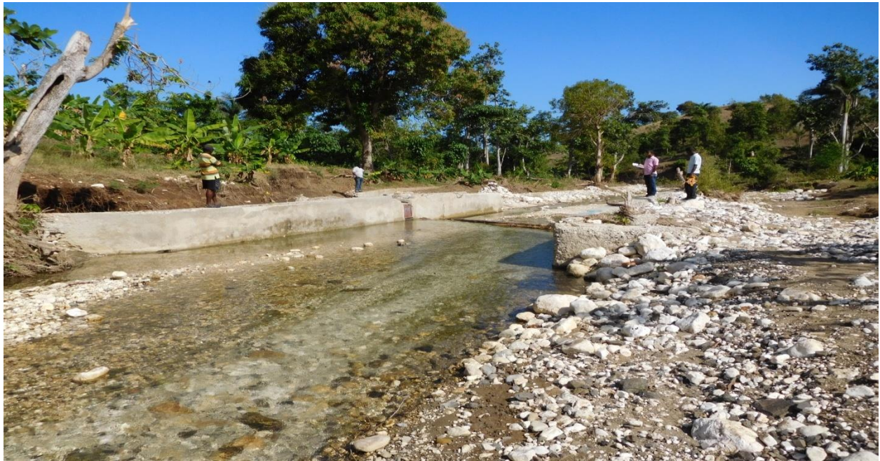
Figure 4: Vue de la prise fusible amont sur le périmètre
